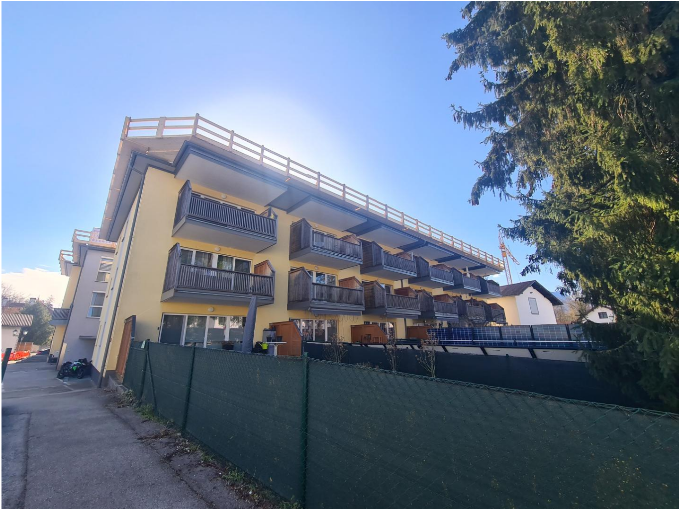
Hausansicht Baufortschritt Aufstockung
