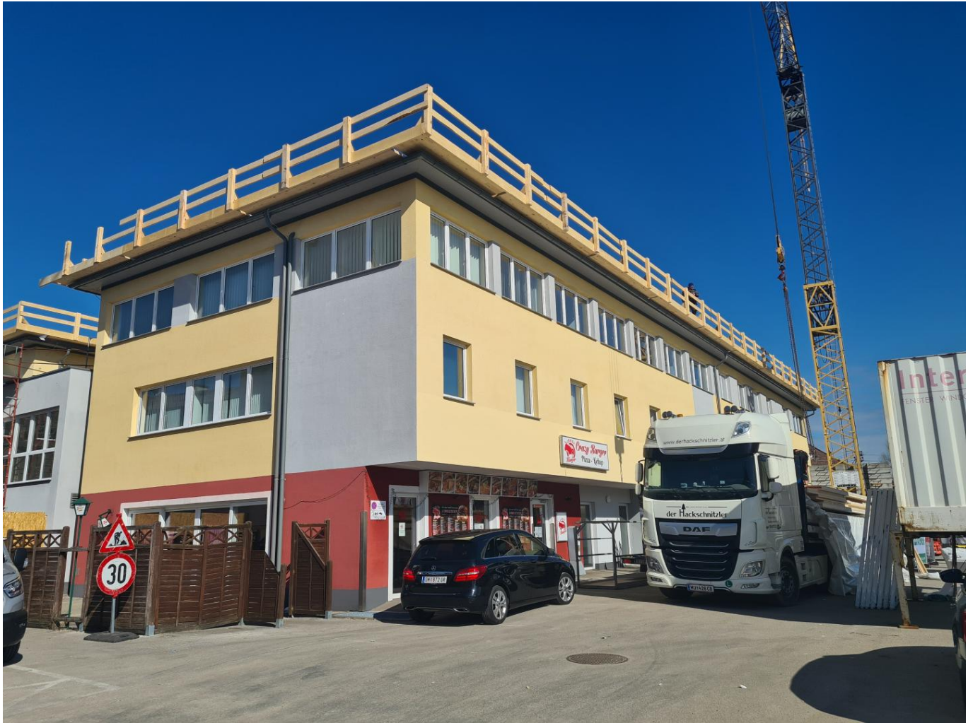
Hausansicht Baufortschritt Aufstockung
