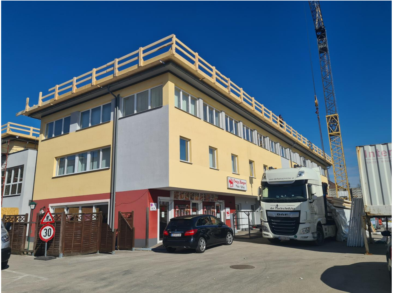
Hausansicht Baufortschritt Aufstockung
