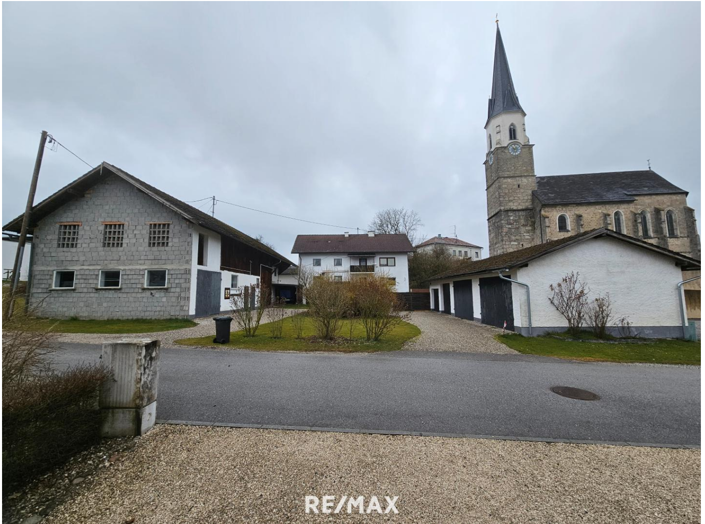
Ansicht Süd mit Garagen und Nebengebäude
