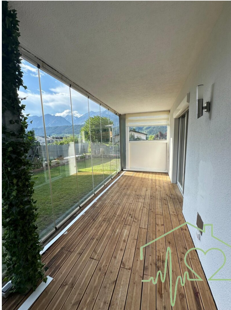
Wintergarten mit Glasschiebeelementen
