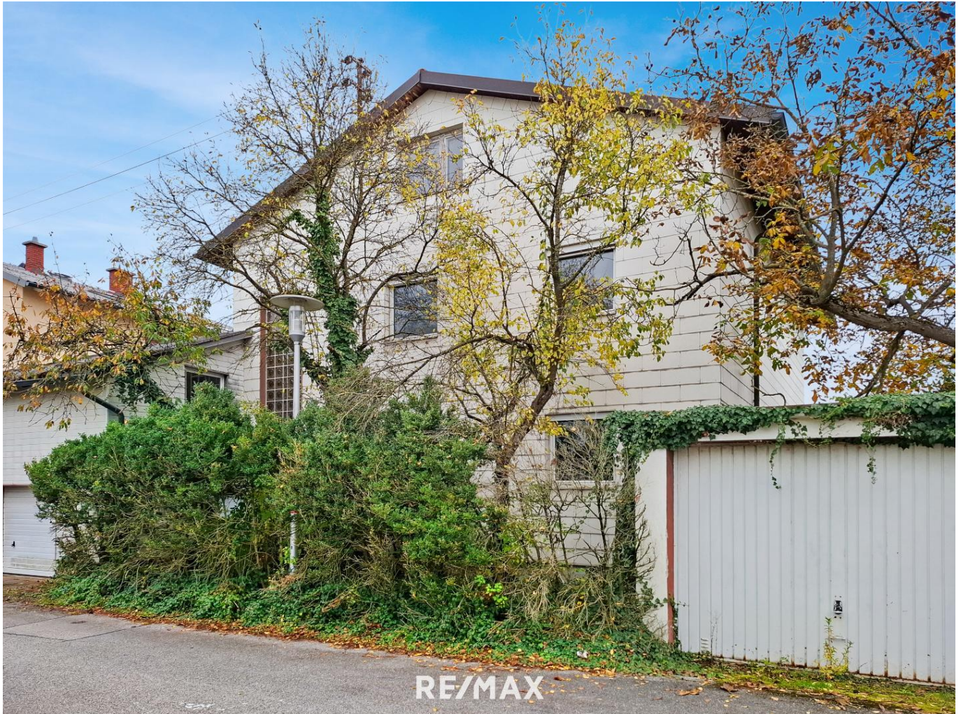
Haus Außenansicht Rückseite
