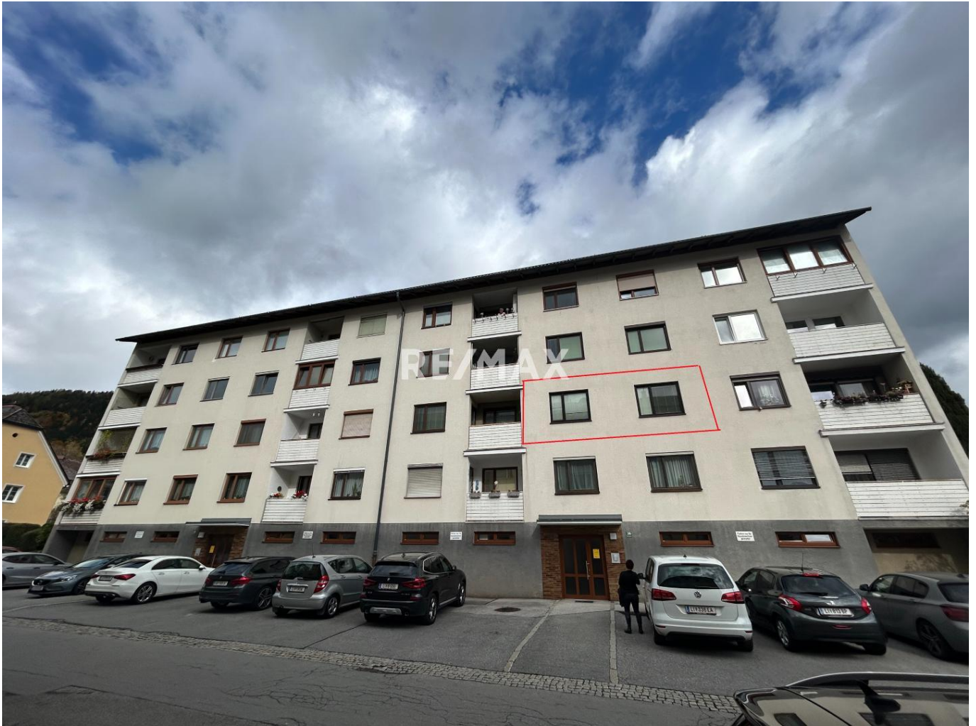
Das Haus von aussen
