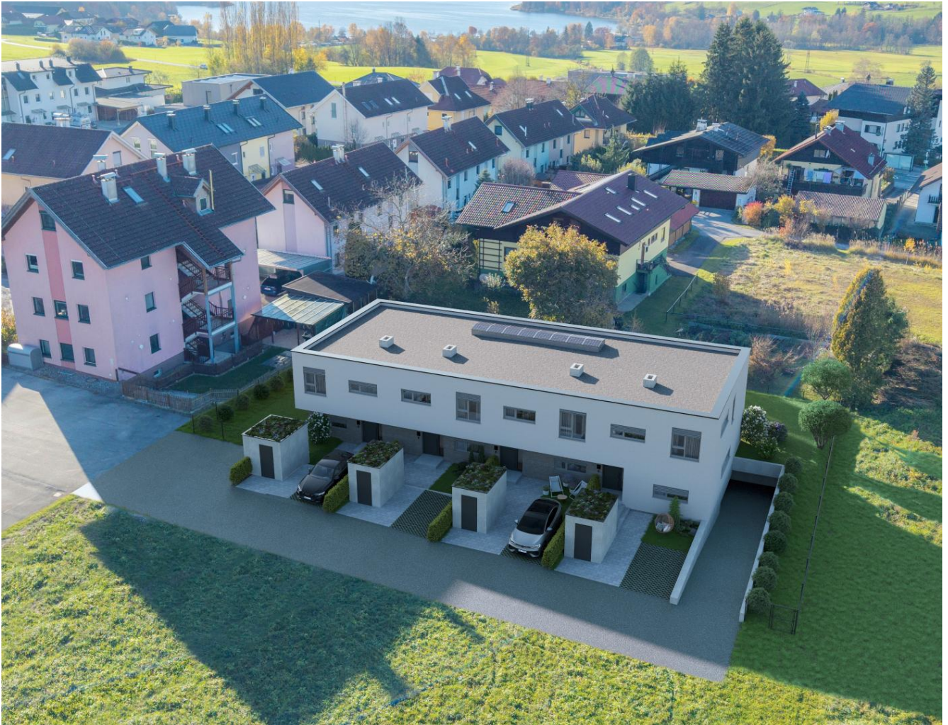
Ansicht Baukörper Vorderseite
