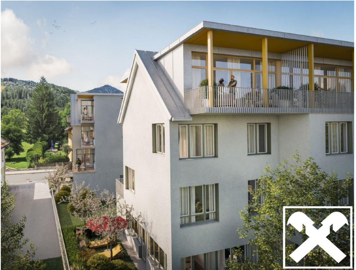
Blick Hofseitig nach Westen
