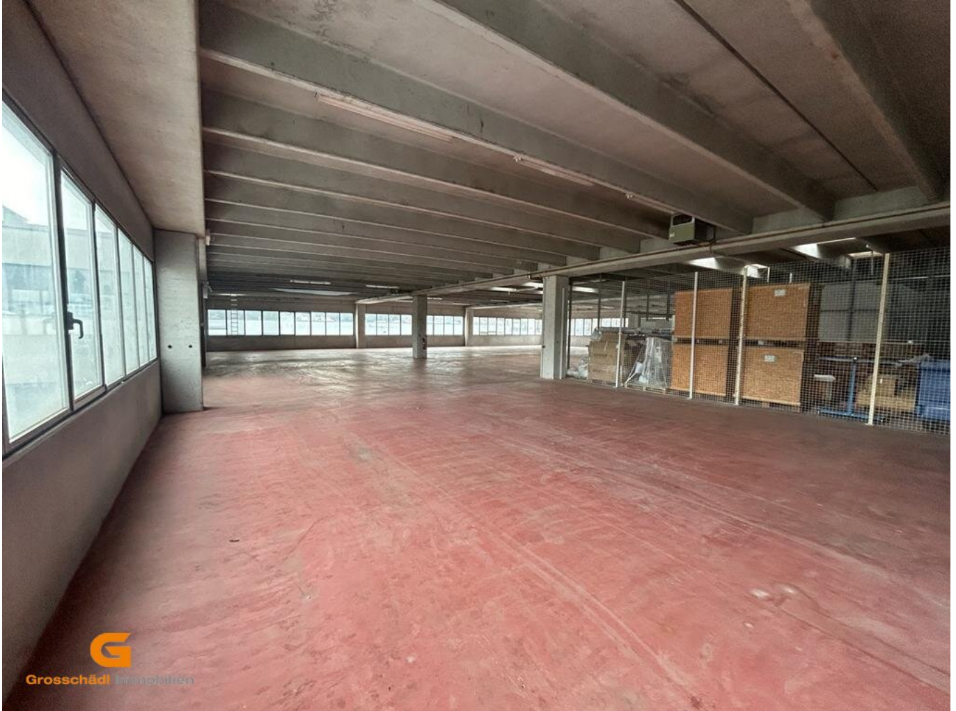
Lager Rückgebäude 1OG
